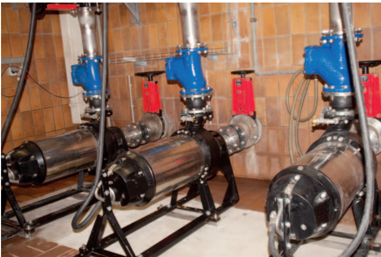
Eine optimale, auf den Einsatzfall zugeschnittene, neue Lösung: 3 horizontal, trocken aufgesetzte SE1.80.100.240
