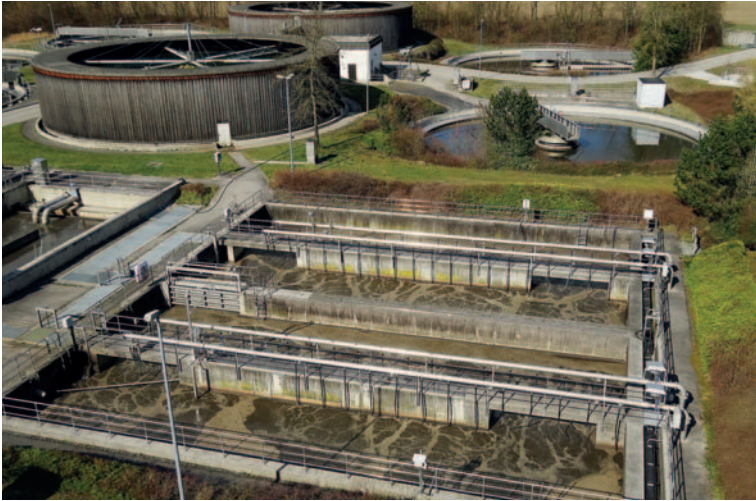
Die Kläranlage ist für 80.000 EW ausgelegt. Ausgereifte Technik sorgt für optimale Abwasseraufbereitung.
